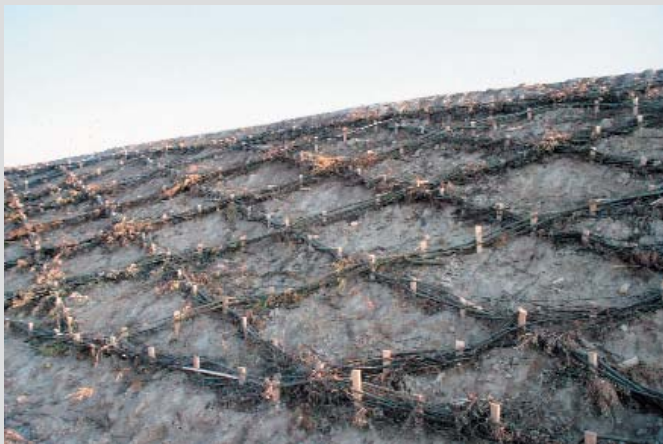
Bild 4: Rautenförmig verlegter Flechtzaun, Reihenabstand 1,5 m, Pflöckabstand 0,5 m; Baustelle Bahn AG, ICE Neubautrasse Mannheim/Stuttgart, Bereich Rollenbergtunnelportal Ost
