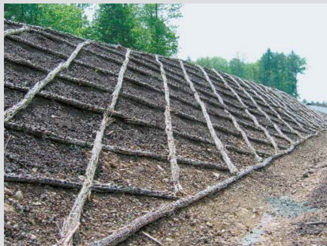
Bild 2: Rautenförmig verlegte Hangfaschinen vor Oberbodenbedeckung, Ortsumgehung Neuhäusel
