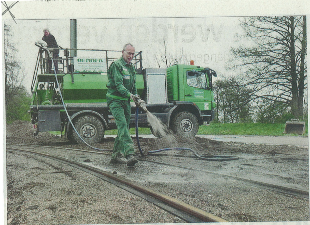
Wenn Wasser versprüht wird, sieht es auch nicht anders aus: Frank Strasser von der Gießener Firma Bender bringt die Rasenmischung auf das Gleisbett aus. Foto: Maria Müssig
