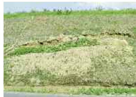
Abb. 4: Abrutschende Oberbodenandekungen nach starken Regenfällen werden künftig voraussichtlich immer häufiger auftreten. Ingenieurbio-logische Bauweisen wie Faschinen oder Rohbodenbegrünungen unter Verzicht auf die Andeckung von Oberboden tragen dazu bei, solche Schäden zu vermeiden.
