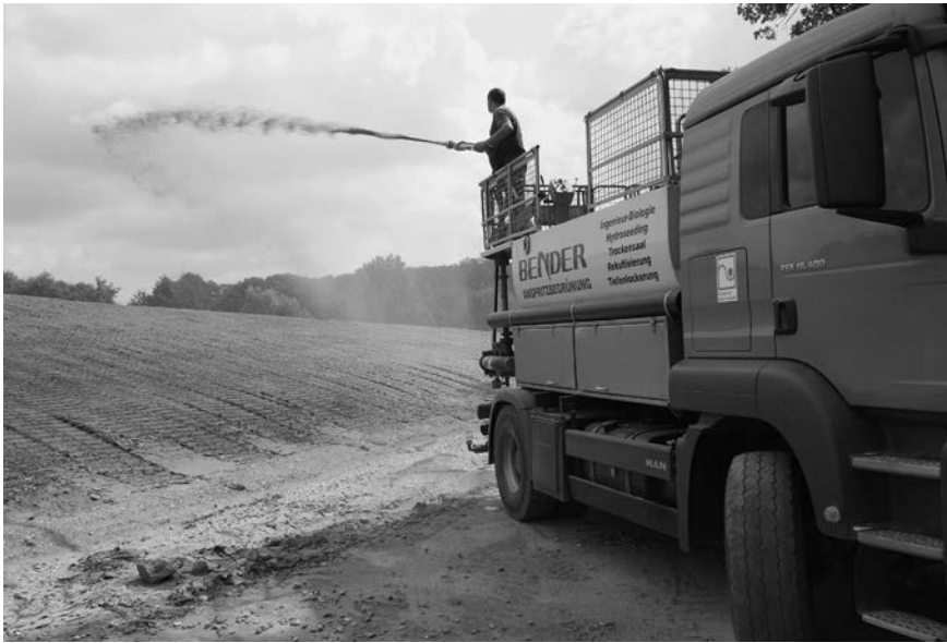
Abb. 1: Nassansaat mit dem Hydroseeder.
